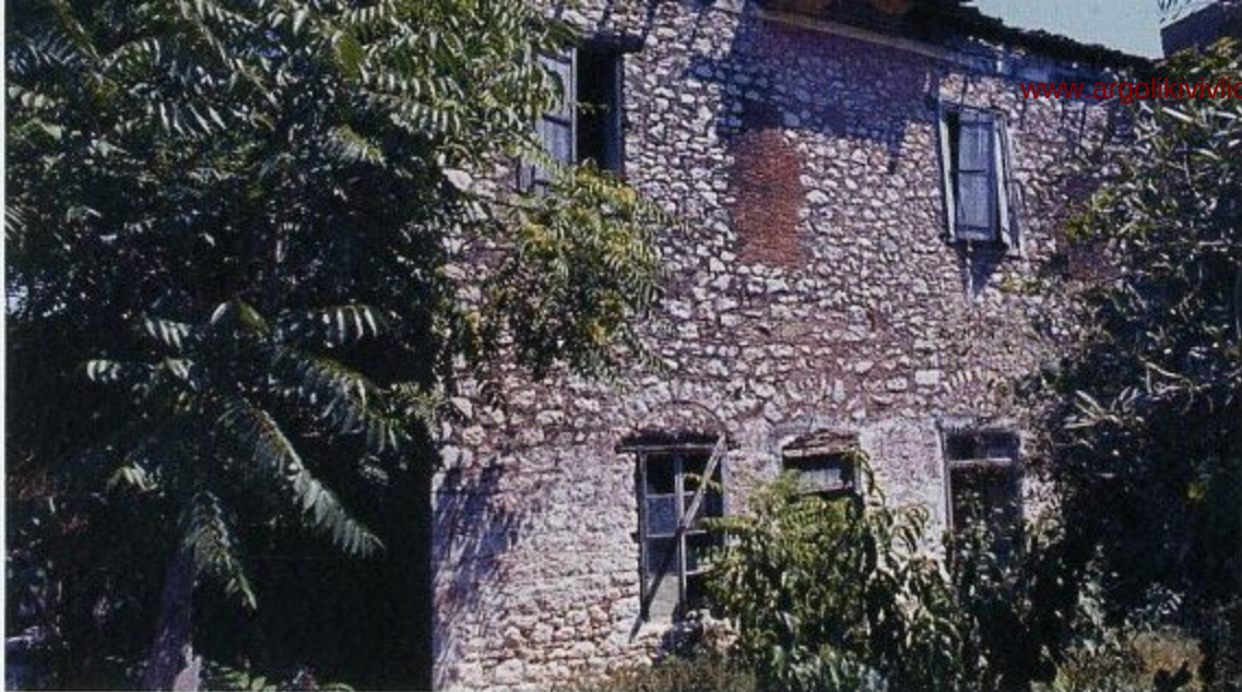
Βόρεια όψη (πριν την αποκατάσταση)
