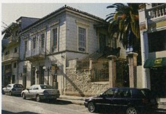
Οικία Μαρίκου πριν την αποκατάσταση
