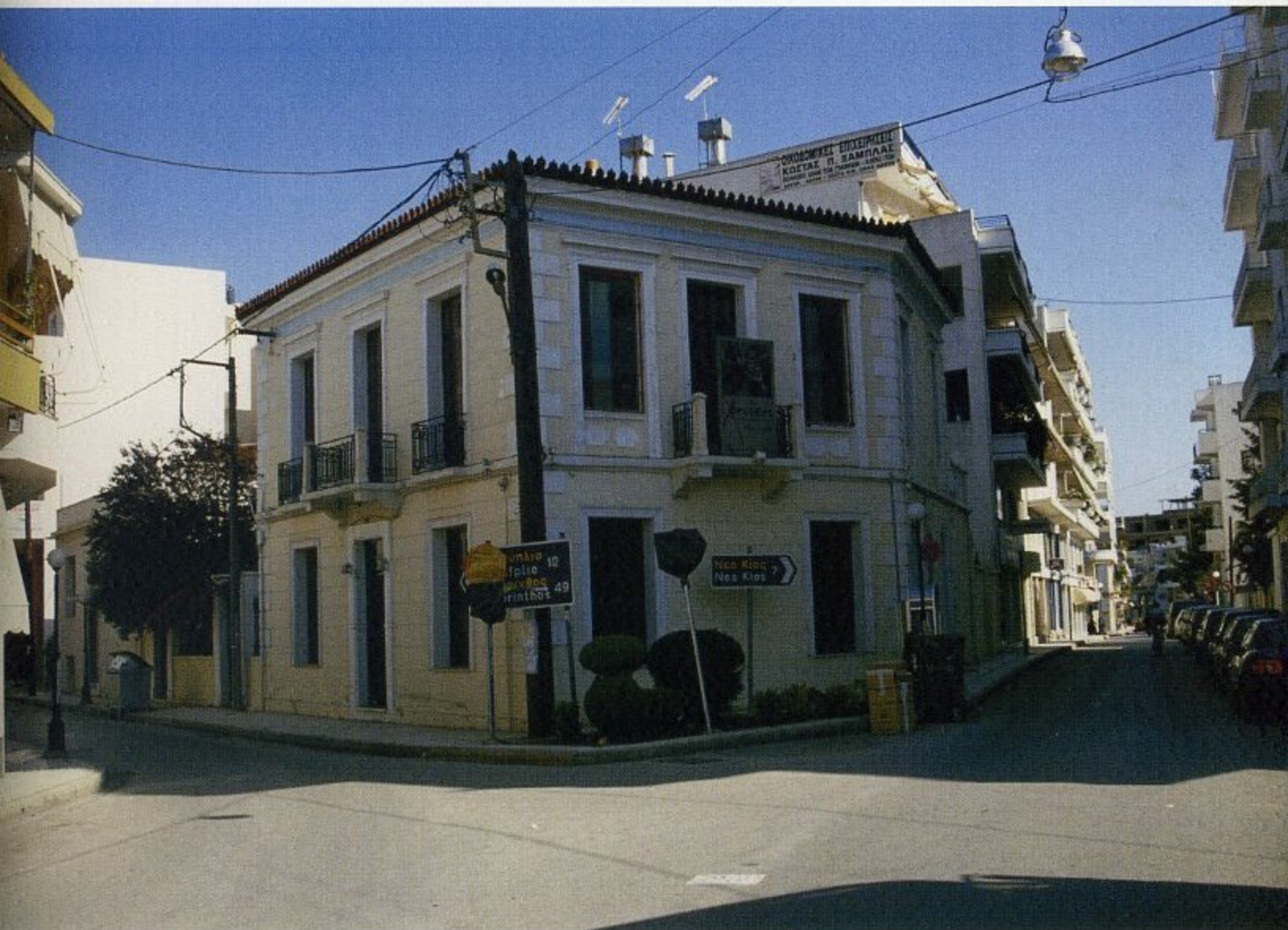
Η σημερινή κατάσταση του κτιρίου
