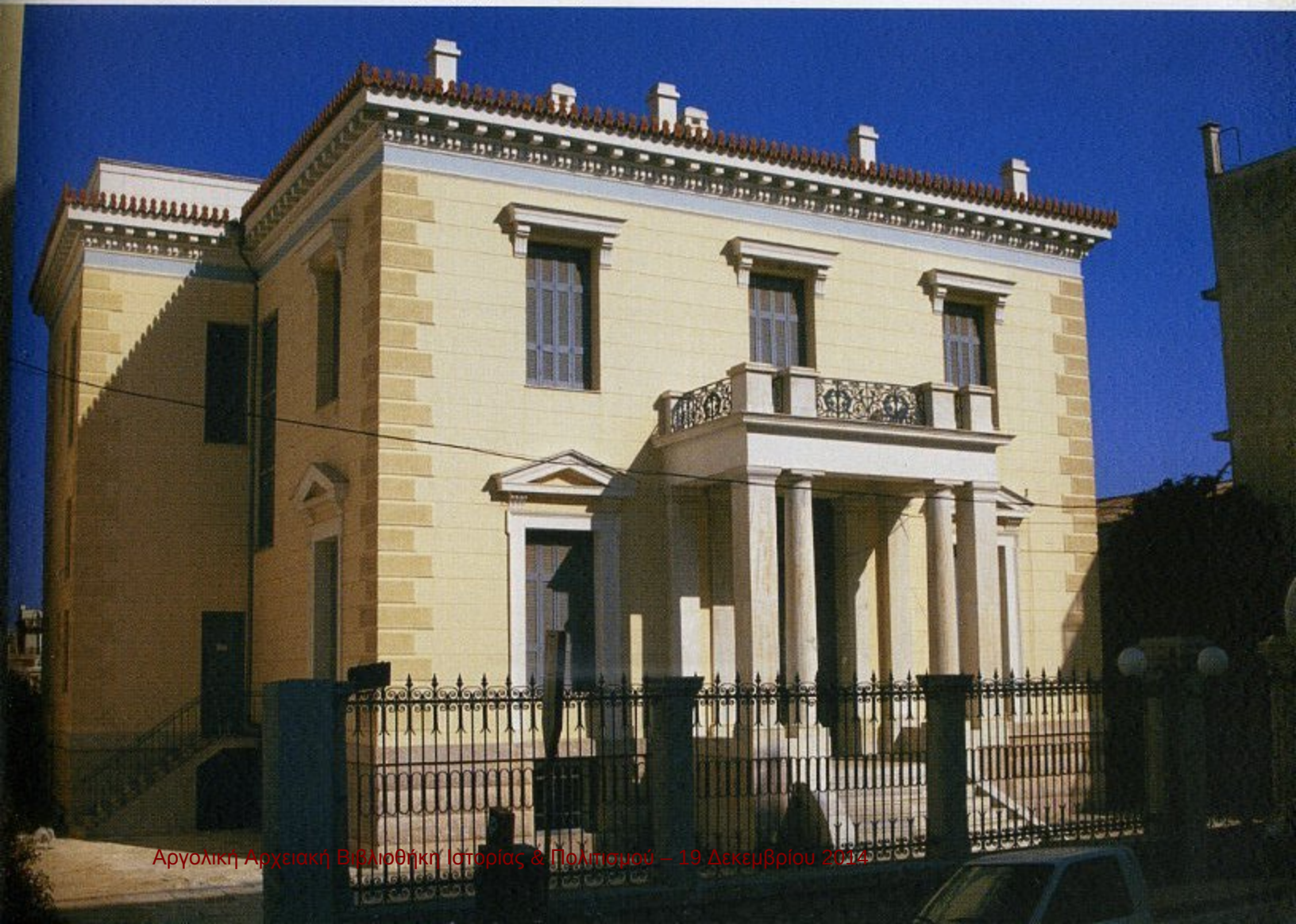
Βορειοδυτική όψη, μετά την αποκατάσταση. (Λήψη φωτο 2006)
