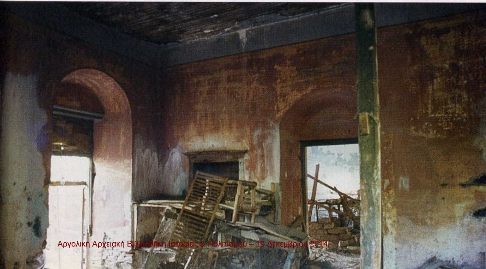
Εσωτερικό ισογείου (πριν την αποκατάσταση)
