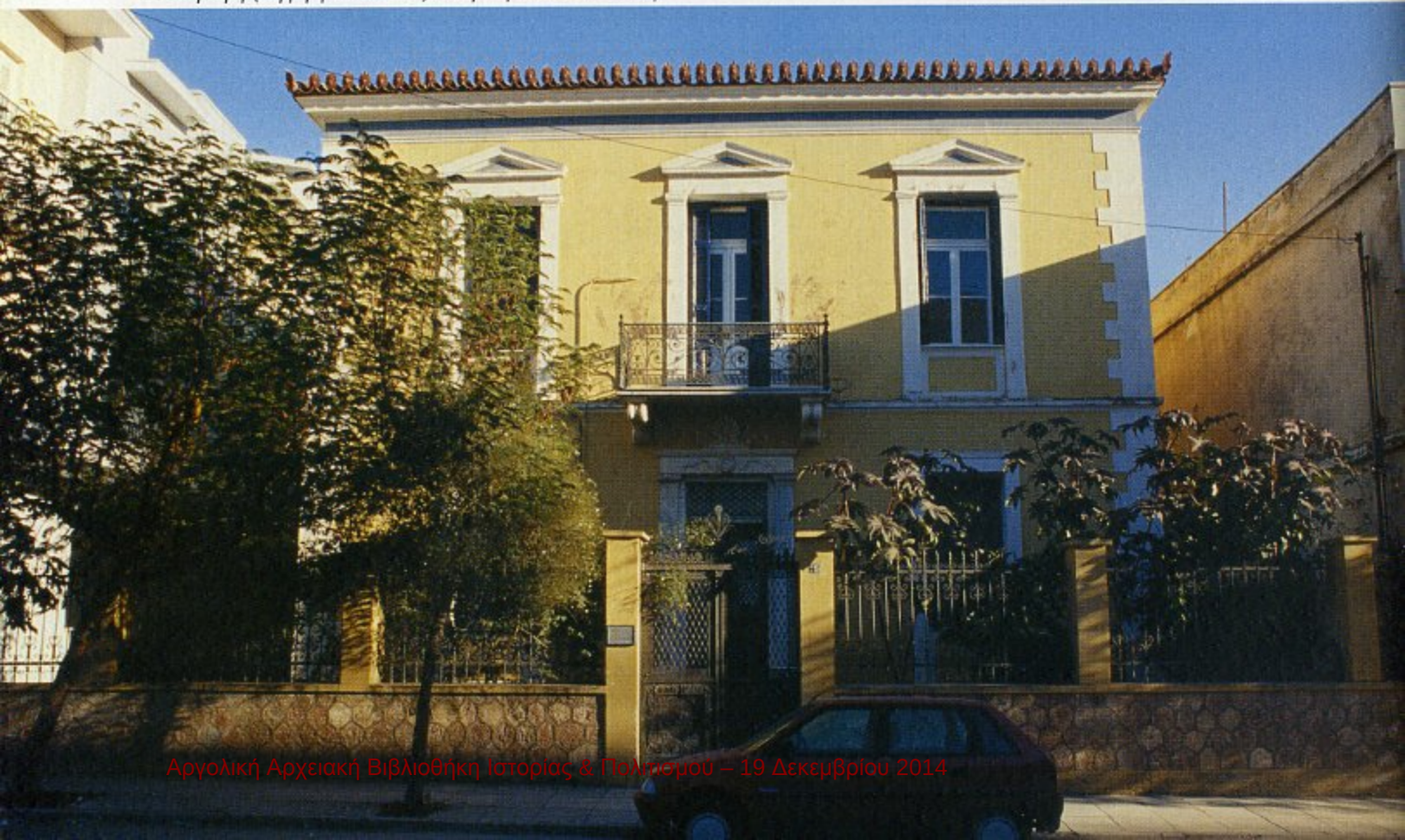
Δυτική όψη (Λήψη φωτό 1987). Μερική αποκατάσταση
