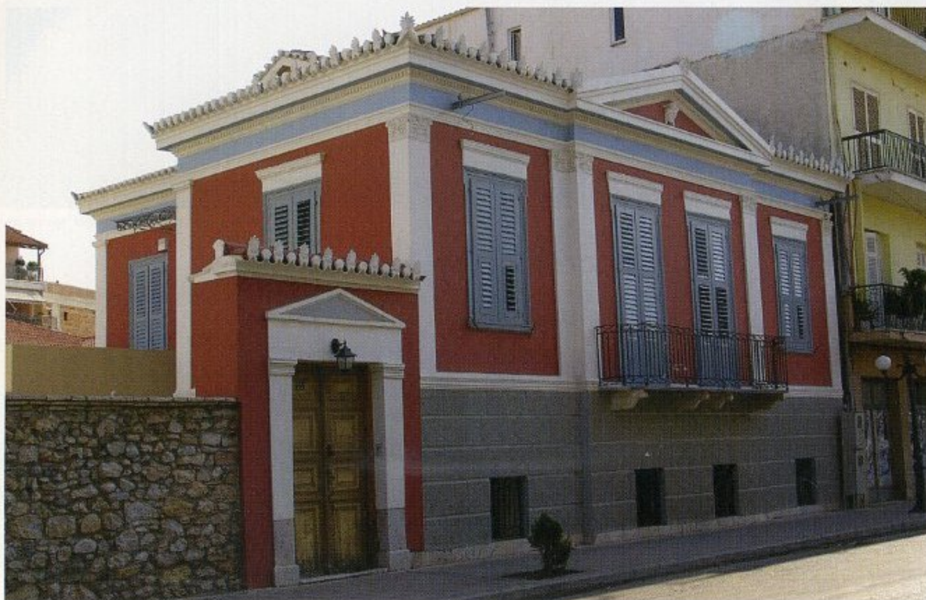
Οικία Θ. Μπόμπου, οδός Βασ. Σοφίας μετά την αποκατάσταση. (Λήψη φωτο 2006)
