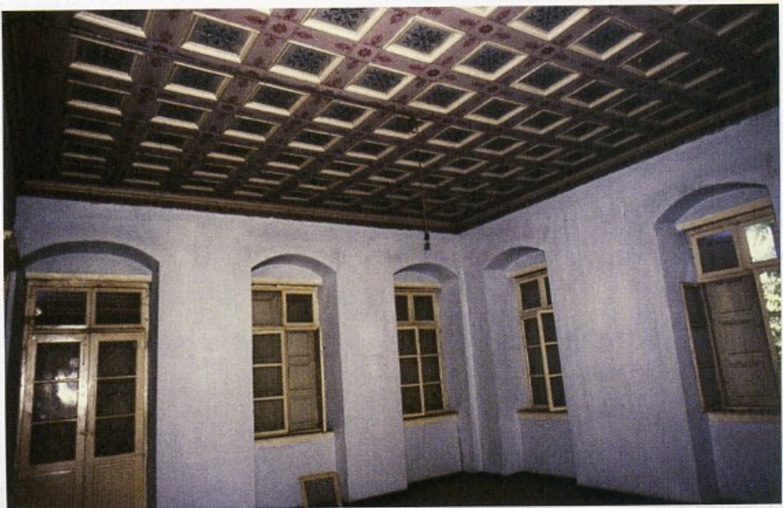
Εσωτερικό (λεπτομέρεια ζωγραφικής ξύλινης οροφής)
