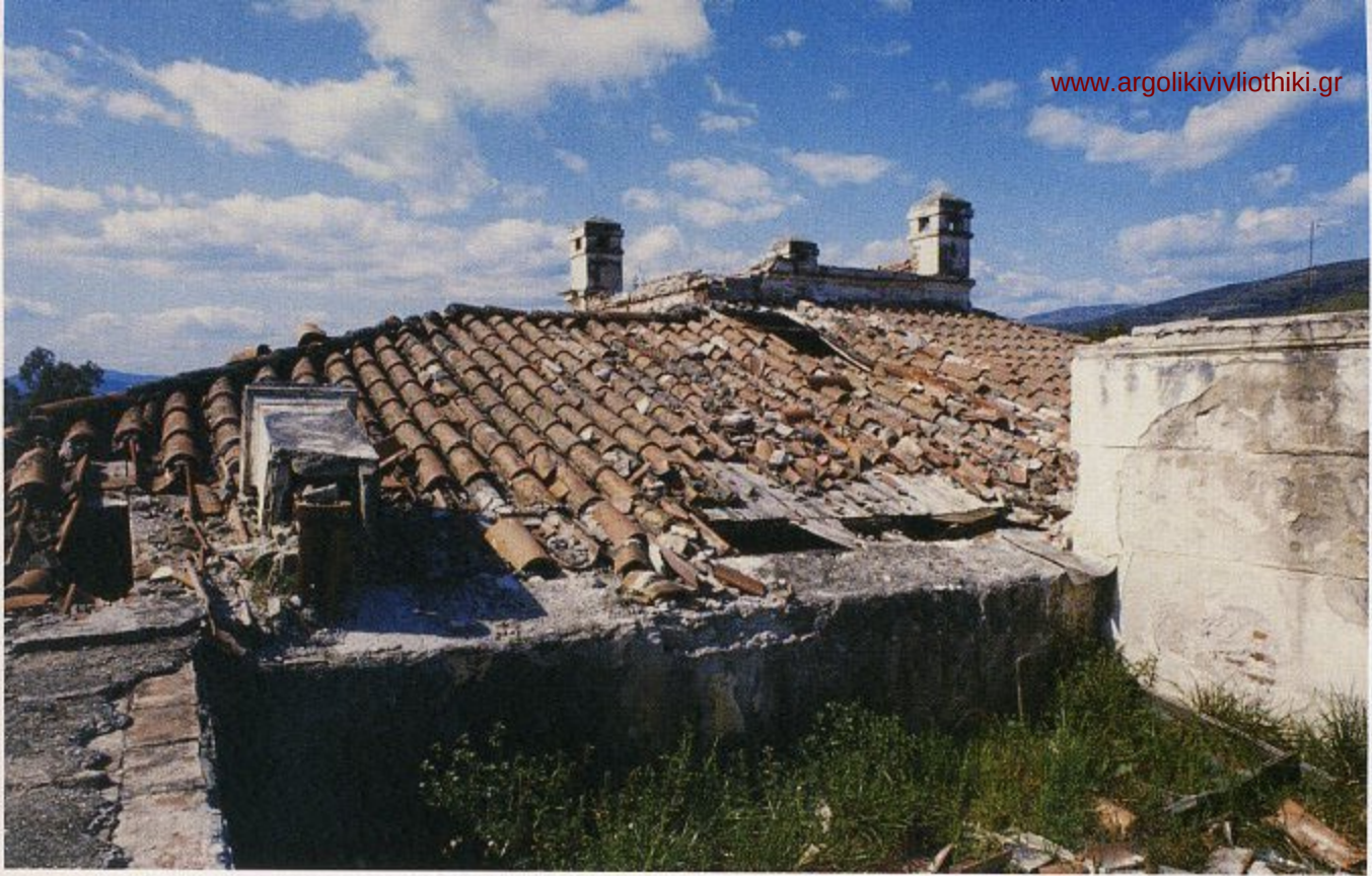
Άποψη δώματος - στέγης (πριν την αποκατάσταση)
