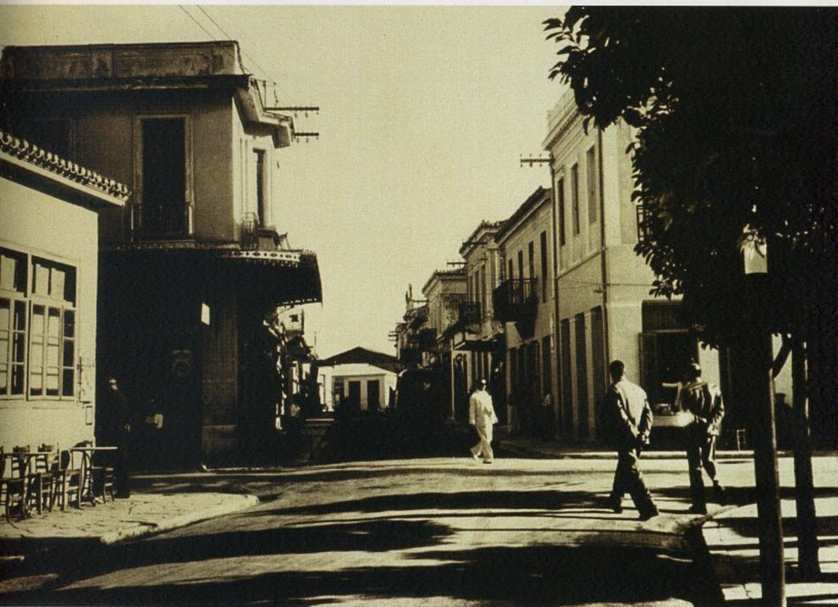
Άποψη της οδού Π. Τσαλδάρη, τη δεκαετία του '50
