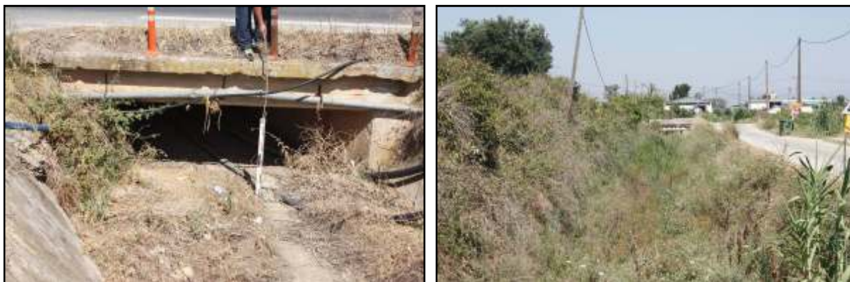
Εικόνα 2.30. Λεπτομέρεια από τη διατομή του πλακοσκεπούς αγωγού στον οποίο ρέει το Κιρίμι, στη διασταύρωση του με την ΠΕΟ Άργους – Τριπόλεως, ύψους 1,2m (αριστερά). Η κοίτη του ρέματος Κιρίμι, ανάντη της συμβολής με τον Ερασίνο (δεξιά).
