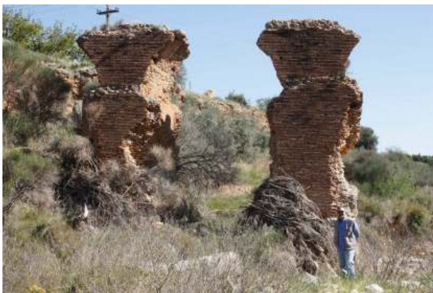
Εικόνα 2.12. Τμήμα από τις κολώνες του Αδριάνειου υδραγωγείου. Στη βάση διακρίνεται σωρός από κλαδιά δένδρων, που μεταφέρθηκαν από τα ανάντη τμήματα της λεκάνης του Ξεριά, κατά τη διάρκεια του πλημμυρικού φαινομένου το Δεκέμβριο του 2012.
