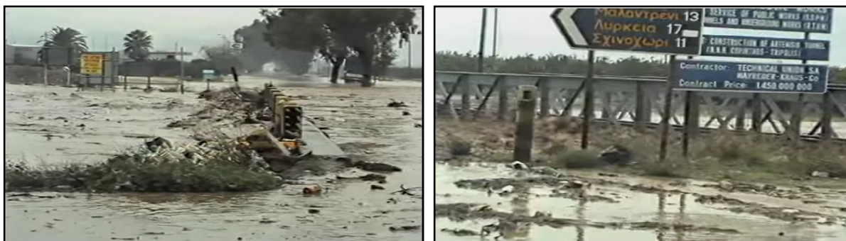
Εικόνα 3.2. Άποψη της κοίτης του χειμάρρου Ινάχου κατά τα έντονα πλημμυρικά φαινόμενα που σημειώθηκαν στις 16-11-1990 στο ανάντη τμήμα της γέφυρας της επαρχιακής οδού Άργους – Κορίνθου (αριστερά) και μεταξύ της ανωτέρω γέφυρας και της γέφυρας της σιδηροδρομικής γραμμής Άργους – Κορίνθου (δεξιά). Πηγή: https://www.youtube.com/watch?v=5Xq7JeZZl6I
