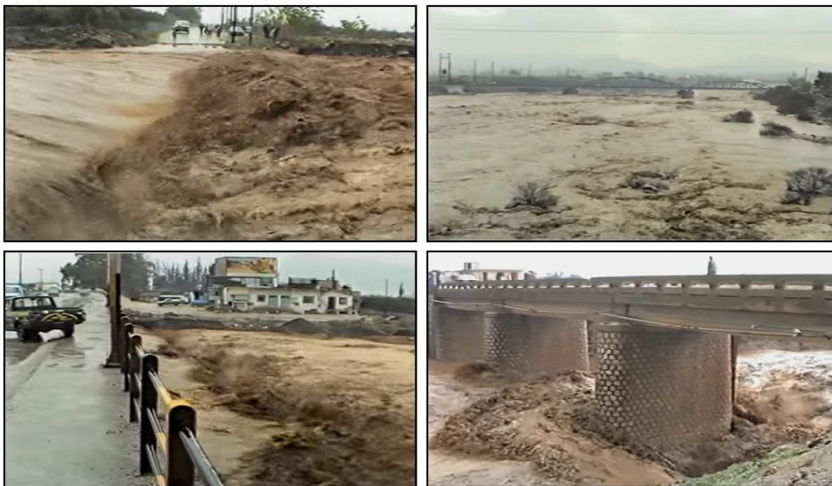
Εικόνα 3.1. Αποψη της κοίτης του χειμάρρου Ξεριά κατά τα έντονα πλημμυρικά φαινόμενα που σημειώθηκαν στις 16-11-1990 στην διάβαση ιρλανδικού τύπου της οδού Ήρας (επάνω αριστερά),
