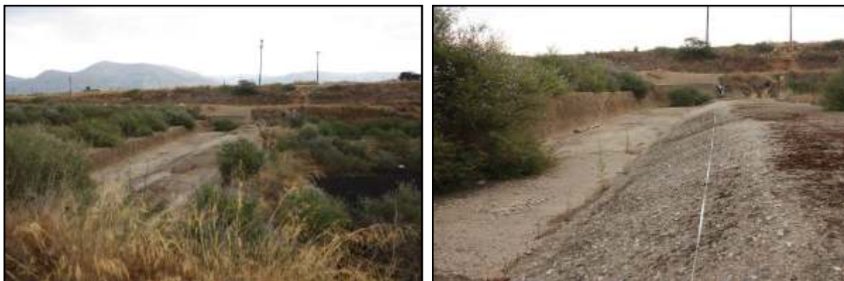
Εικόνα 2.22. Τεχνικό έργο (αναβαθμός με υπερχειλιστή) εντός της κοίτης του Ινάχου σε θέση κατάντη της γέφυρας της επαρχιακής οδού Άργος – Ινάχου.
