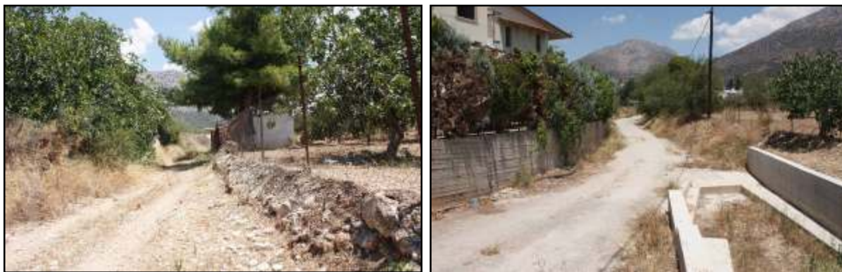
Εικόνα 2.38. Η κοίτη – δρόμος που καταλήγει εντός του οικισμού των Μυκηνών από το φαράγγι του Χάθου (αριστερά). Η διαμόρφωση της κοίτης με τεχνικό λίγο πριν το δρόμο Μυκηνών – Μοναστηρακίου, όπου υπάρχει μικρή γέφυρα.
