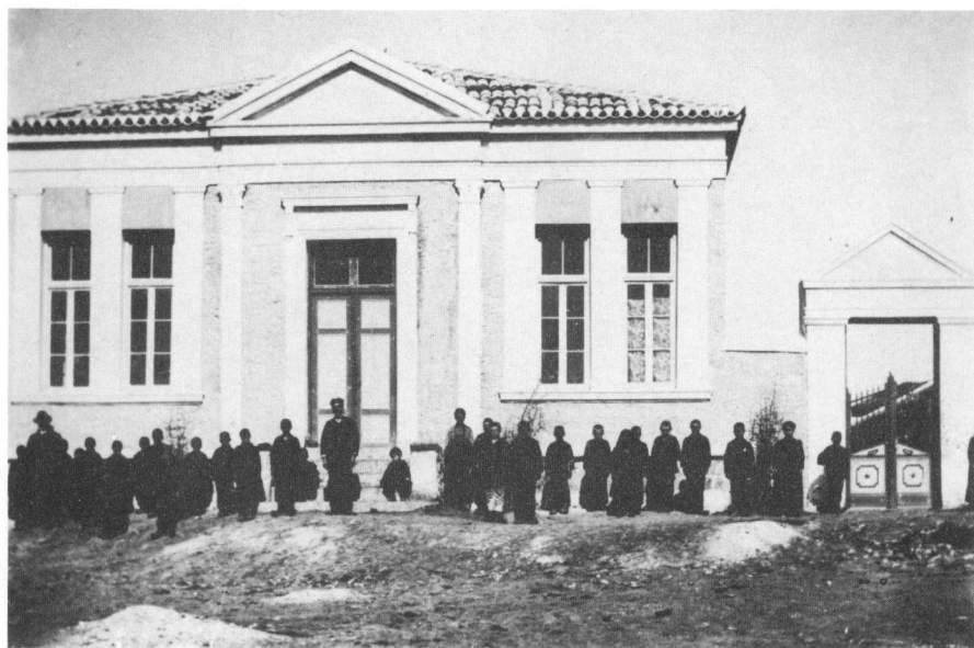
53. Μονοτάξιο δημοτικό σχολείο Φθίας.
