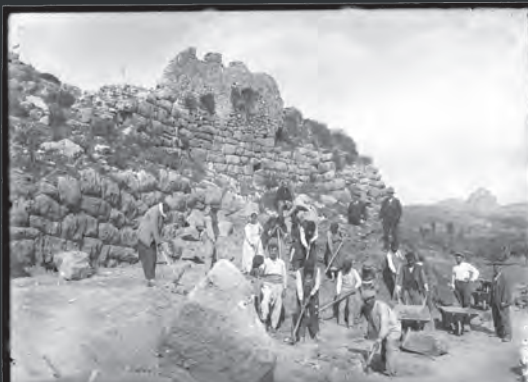
46 Ο αναλημματικός τοίχος της κλίμακας προς την ακρόπολη κατά τις ανασκαφικές εργασίες.
